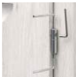
regulace nastavitelných 3D čepových závěsů
