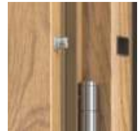
4 bezpečnostní trny proti vylomění
