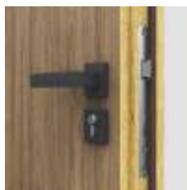
zámek pro cylindrickou vložku
