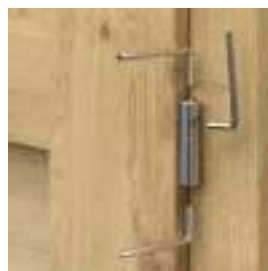
seřízení čepového závěsu 3D
