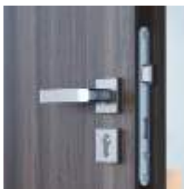
zámek pro cylindrickou vložku
