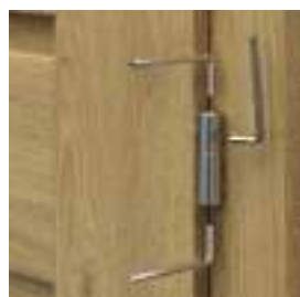
seřízení čepového závěsu 3D
