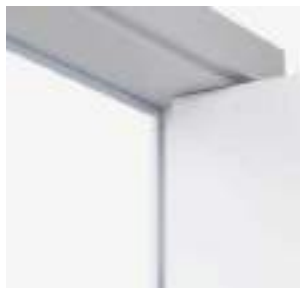
Roh zárubně z vnitřní strany
