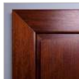
spojování lišt pod úhlem 45°
