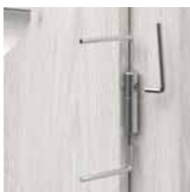
seřízení čepového závěsu 3D
